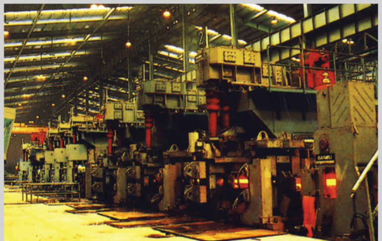
Automatic Rolling Mill โรงรีดเหล็กเส้นอัตโนมัติ
